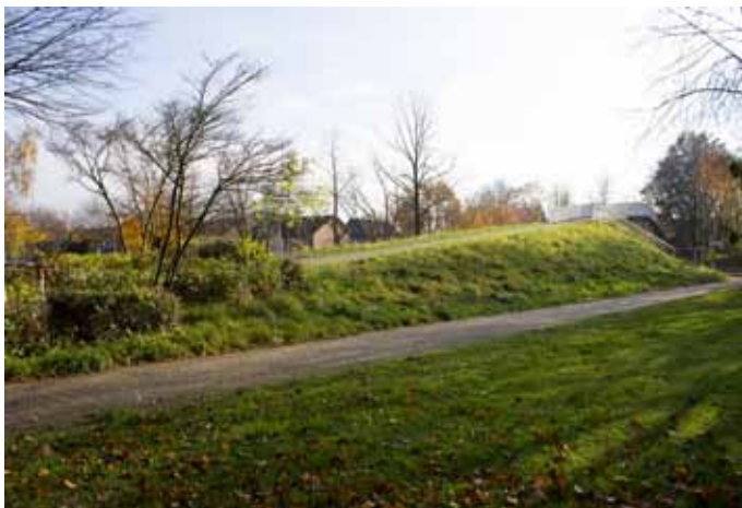
Die steile Rampe der Fußgängerbrücke Straelener Straße
