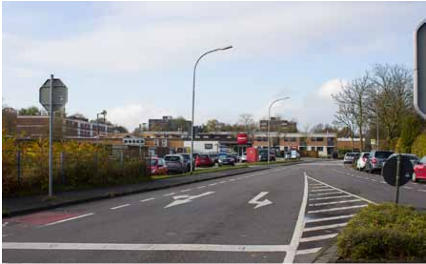
Aktuelle Situation an der Einmündung der Söderblomstraße
